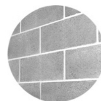
Bloco de betão face à vista nas paredes dos arrumos
